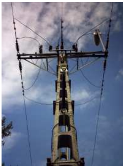
Widok czujnika zamontowanego na słupie odporowym BSW-12(14)
