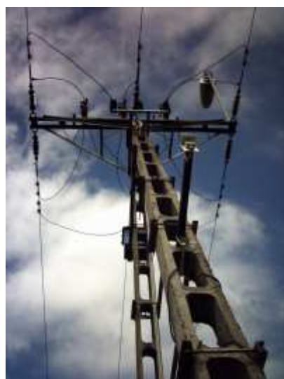
Widok czujnika zamontowanego na słupie odporowym BSW-12(14)
